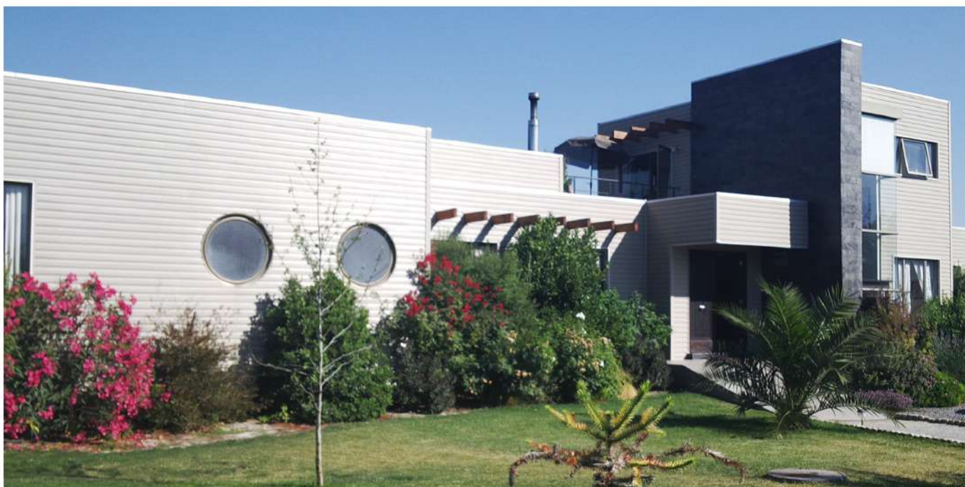
Aplicação em fachada de Siding Americano na cor branca
