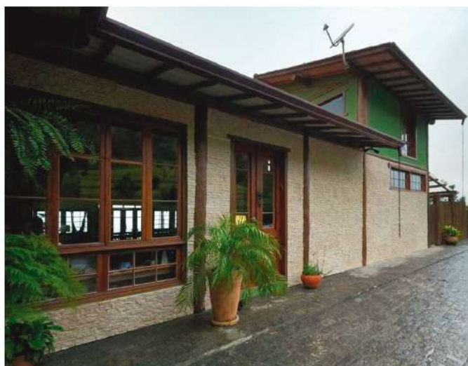
Aplicação em fachada
