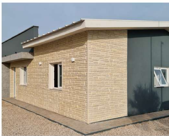
Aplicação em fachada
