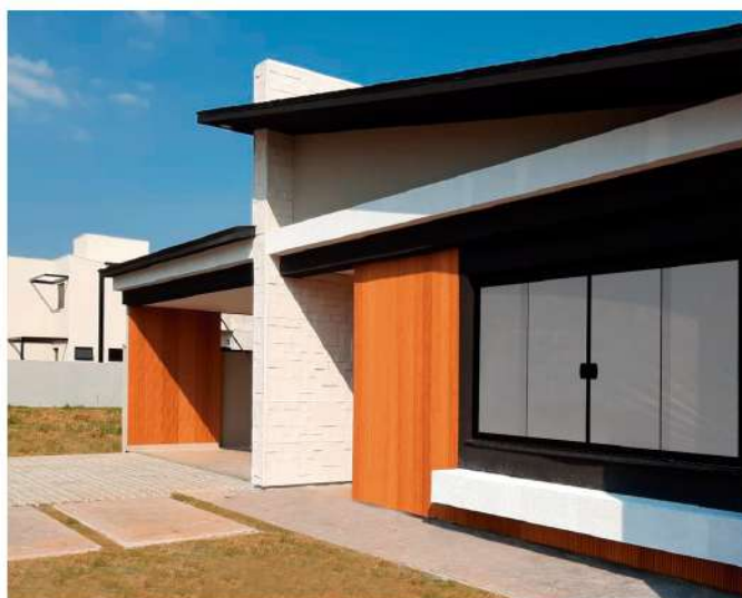
Aplicação em fachada
