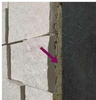
Para evitar sujeiras desnecessárias no processo de instalação recomendamos que não se utilize espuma expansiva em excesso, pois rendimento dela é alto.
