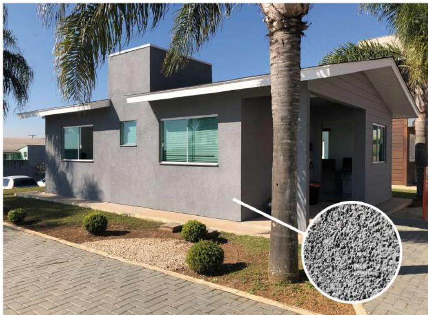
A Textura Sika Eifs é ideal para a utilização no sistema EIFs, que exige um acabamento diferenciado. Para as demais vedações do Light Steel Framing é indicada a Textura Sika Acrílica, que também pode ser utilizada em construções convencionais.
